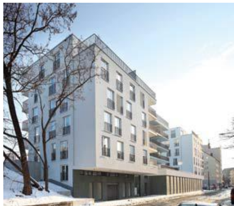
Ansicht von der Hedderichstraße mit farblich abgesetztem Sockel und räumlich differenzierter Gebäudekante zum öffentlichen Straßenraum ↑
