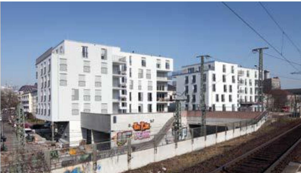
Südseite mit Garagenzufahrt und S-Bahn-Tunnel ↑
